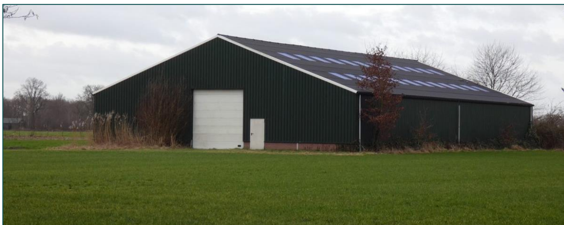
Figuur 3.4 Te slopen schuur aan de Molenweg.
