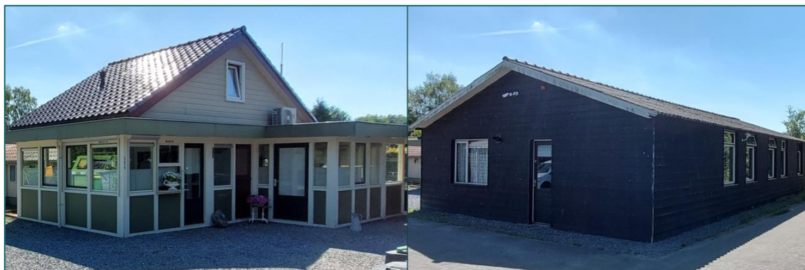
Figuur 1.3 Enkele van de te slopen gebouwen, links de receptie en rechts de schuur.
