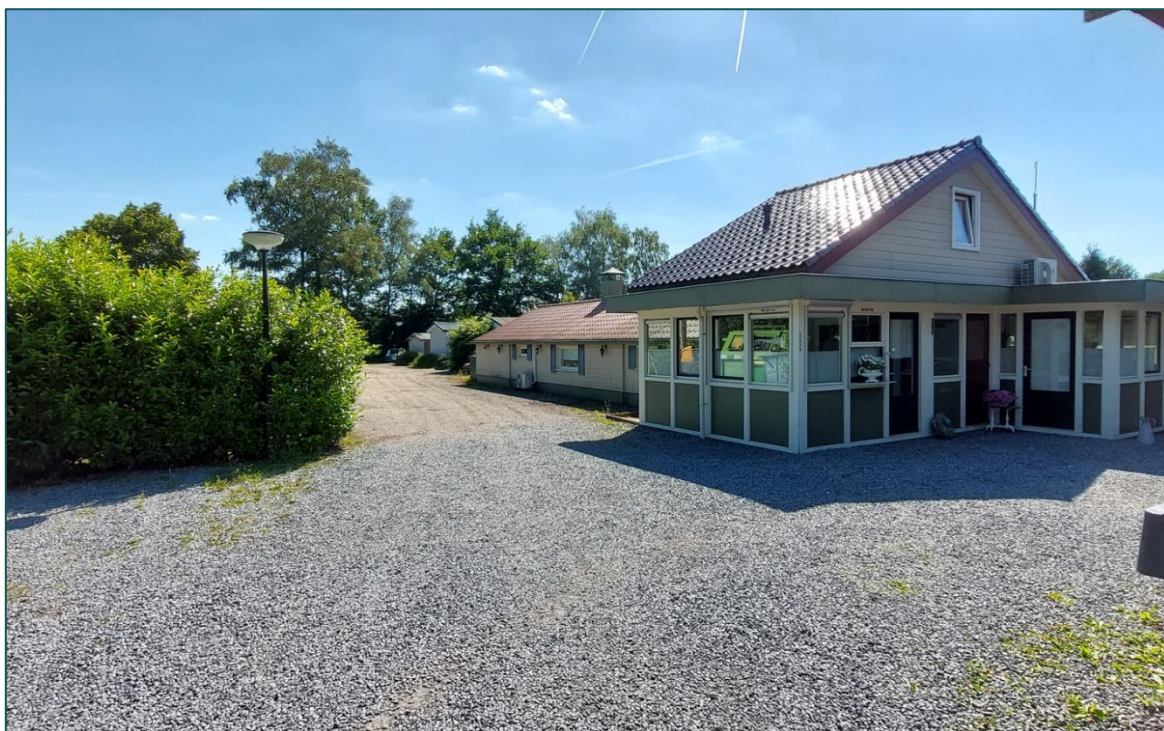
Figuur 1 De planlocatie is gelegen op voormalig bungalowpark 'Landrust' en bestaat uit schuur, receptie en drie bungalows. Beoogde ontwikkeling betreft de sloop van de aanwezige bebouwing t.b.v. een nieuwbouwwoning en werkschuur.
