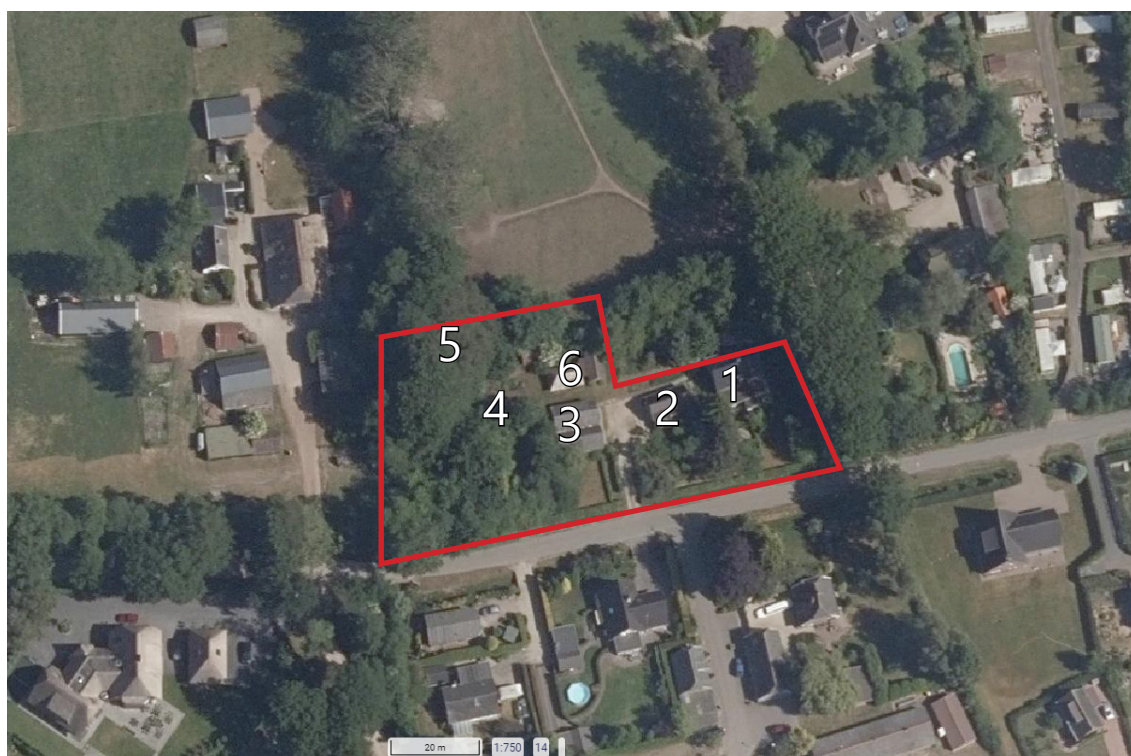
Afbeelding 1.2: Luchtfoto met de globale begrenzing van het plangebied (rood kader). 1 = monumentaal woonhuis, 2 = zomerhuis, 3 t/m 6 = bijgebouwen. Gebouw 1 en 2 zijn geschikt voor vleermuizen, de overige gebouwen niet. Bron ondergrond: Pdok.nl/viewer, luchtfoto.
