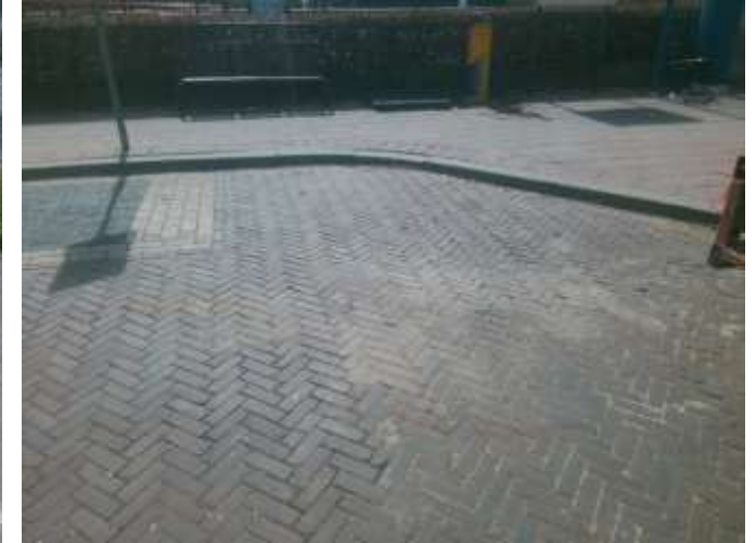
Foto 9: Locatie mechanische boring 222 noordzijde spoor
