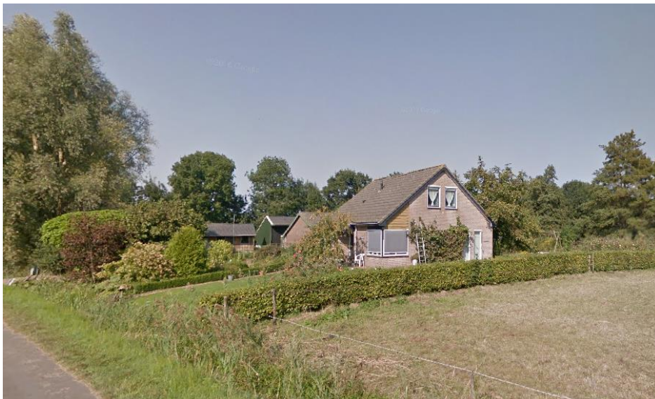
Impressie plangebied, bedrijfswoning gezien vanaf de Krommeweg (bron: google streetview)
