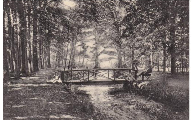
Eenvoudige brug over een watergang
