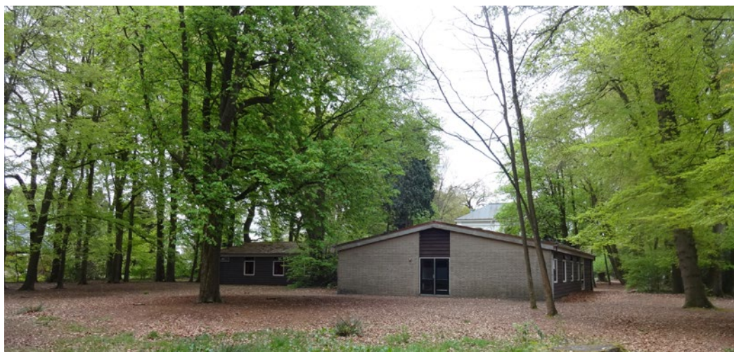
Verouderde recreatieverblijven aan de noordzijde
