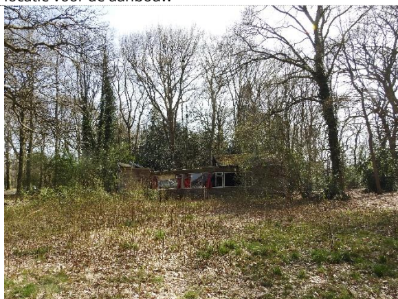
Open plek in het parkbos met op de achtergrond een oude, ingestorte loods
