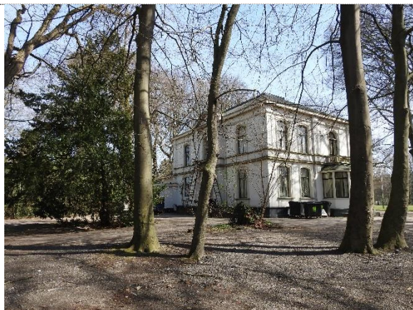
Achterzijde landhuis met halfverharde parkeerplaats, de locatie voor de aanbouw
