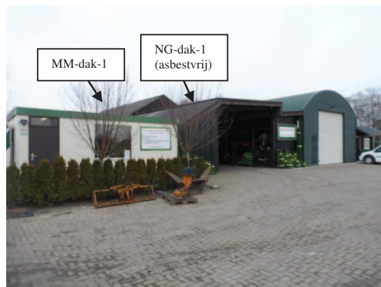
Foto 2: Geïntervieweerde schuur 1 waaronder romneyloods en kantoorunit vanuit noordoostelijke richting gezien. Dakbedekking is gedeeltelijk asbesthoudend en gedeeltelijk asbestvrij. (zie foto 3 en 4)
