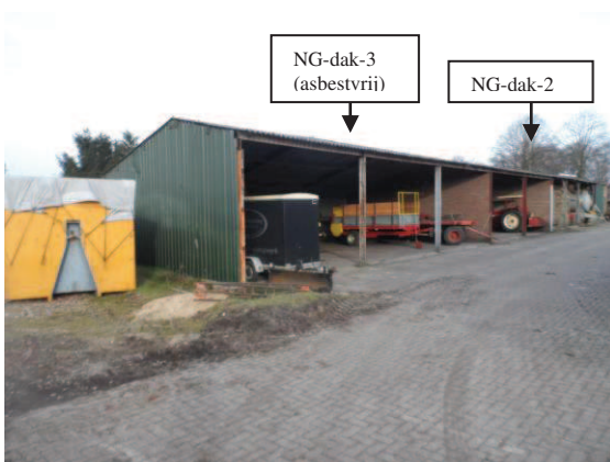
Foto 10: Geïntervieweerde schuur 3 met asbesthoudende en asbestvrije golfplaat als dakbedekking vanuit oostelijke richting gezien.
