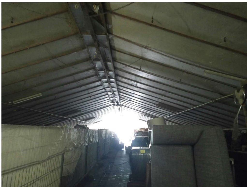
Foto 3: Binnenkant van één van de schuren. De bovenkant is helemaal afgesloten met isolatie en platen waardoor er geen ruimte is voor vleermuizen of andere dieren.
