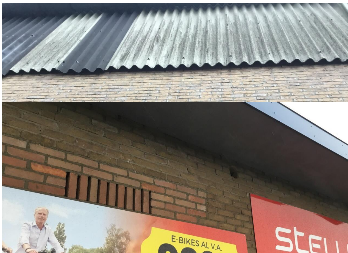
Afbeelding 5.7 Impressie van holten/spleten op de bebouwing binnen het projectgebied dat dienst kan doen als rustplaats voor gebouwbewonende vleermuizen
