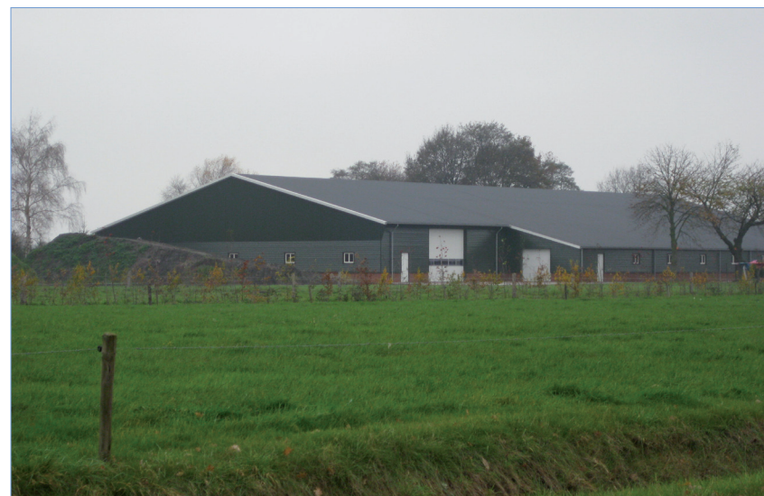
Traditionele opslagschuur met stalen bekleding
