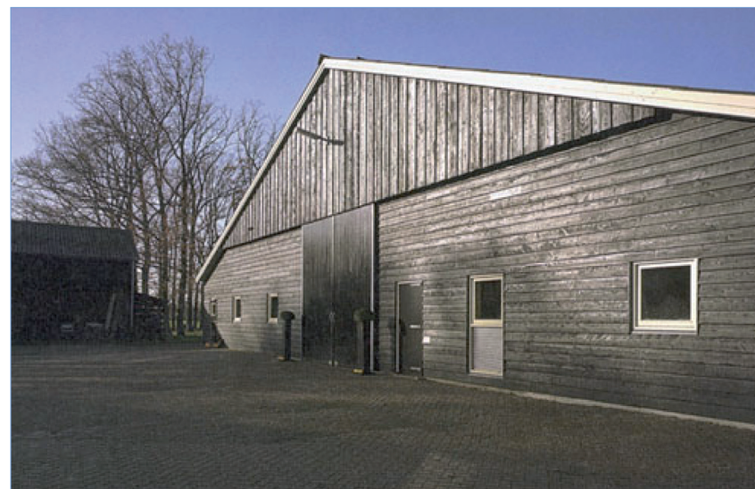
Traditionele stal met houten gevelbekleding
