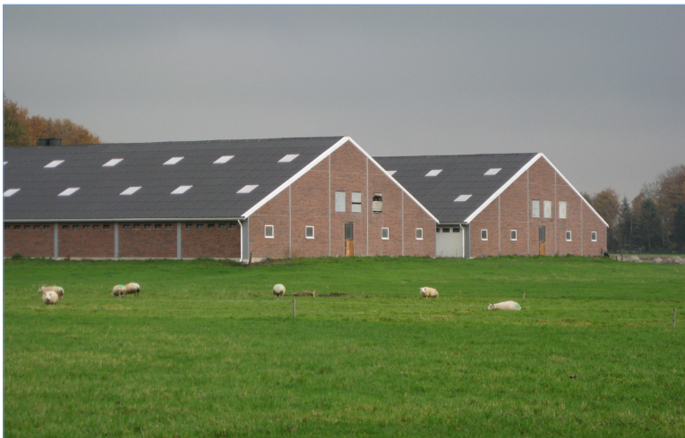
Verfijning in de gevelindeling maakt het gesloten karakter aantrekkelijker
