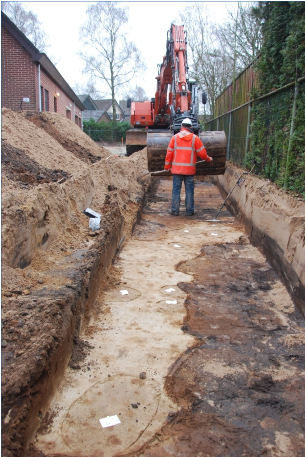
Figuur 6. Aanleg van werkput 1.
