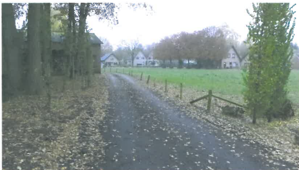
Foto 3: met half-verhardingsmateriaal verharde toegangsweg naar nr. 67
