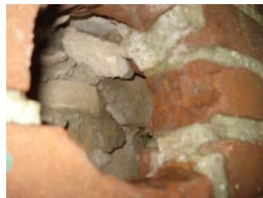
Foto's : Indrukken beperkte ongeschiktheid opstallen. Binnenkant zuidzijde (enkelwandig) en open spouw noordzijde.
