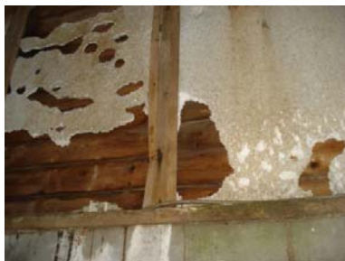
Foto's : Indrukken beperkte ongeschiktheid opstallen. Binnenkant zuidzijde (enkelwandig) en open spouw noordzijde.
