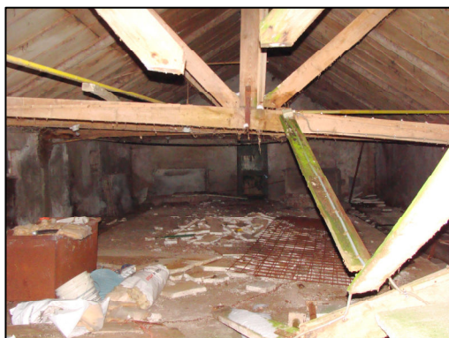
Foto 3. Binnenzijde een van de stallen.
