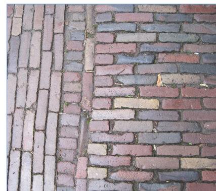
Inrichting met klinkers, gras of halfverharding.
