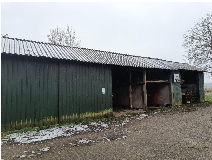
7 (deels) open kapschuur
