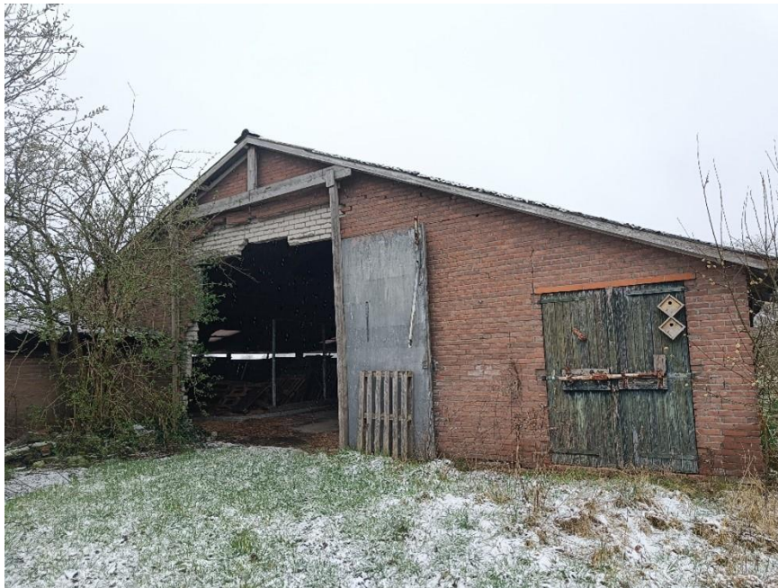
14 Buitenzijde melkstal, toegang tot spouwmuur en nestkastjes aanwezig
