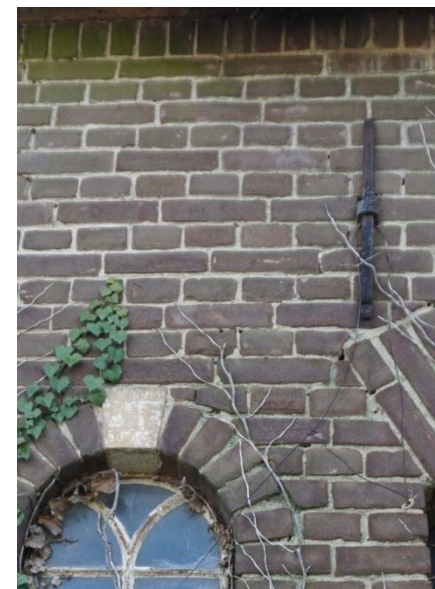
Metselwerk van de noordgevel uit 1911
