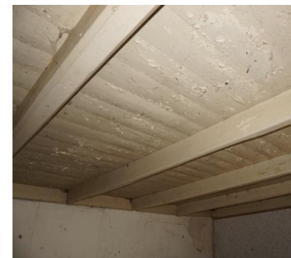
Balklaag boven opkamer 0.5
