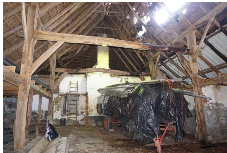
Overzicht van de gebintconstructie in 0.7
