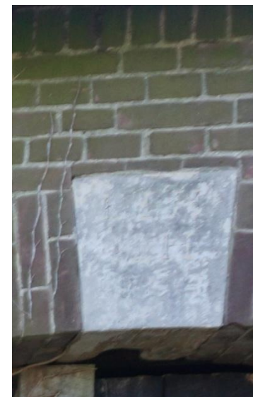
Sluitsteen uit 1834 in de noordgevel
