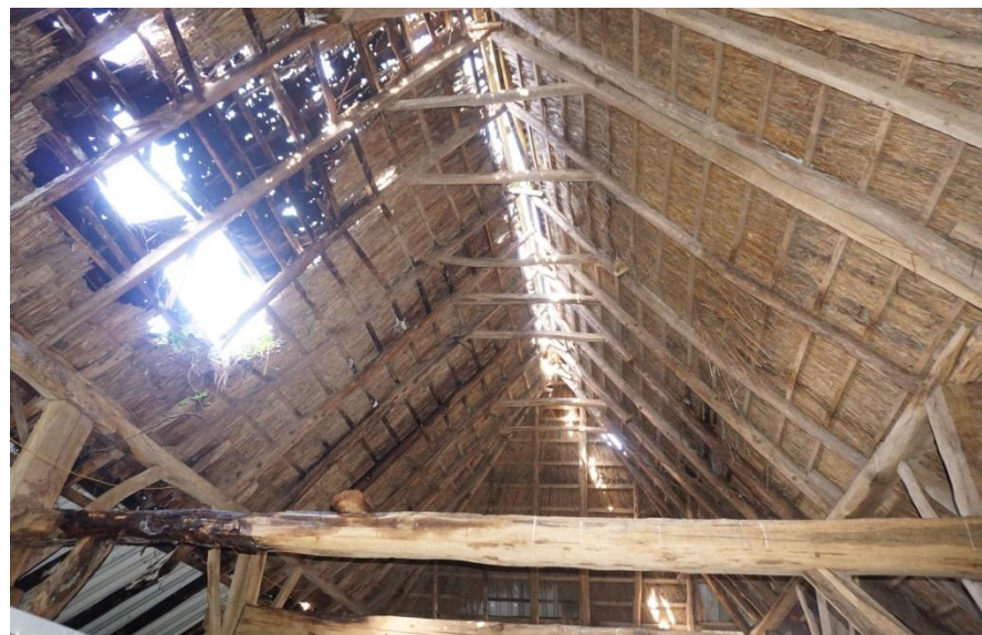
Sporenkap boven de deel 0.7
