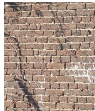
Metselwerk van de oostgevel uit 1886
