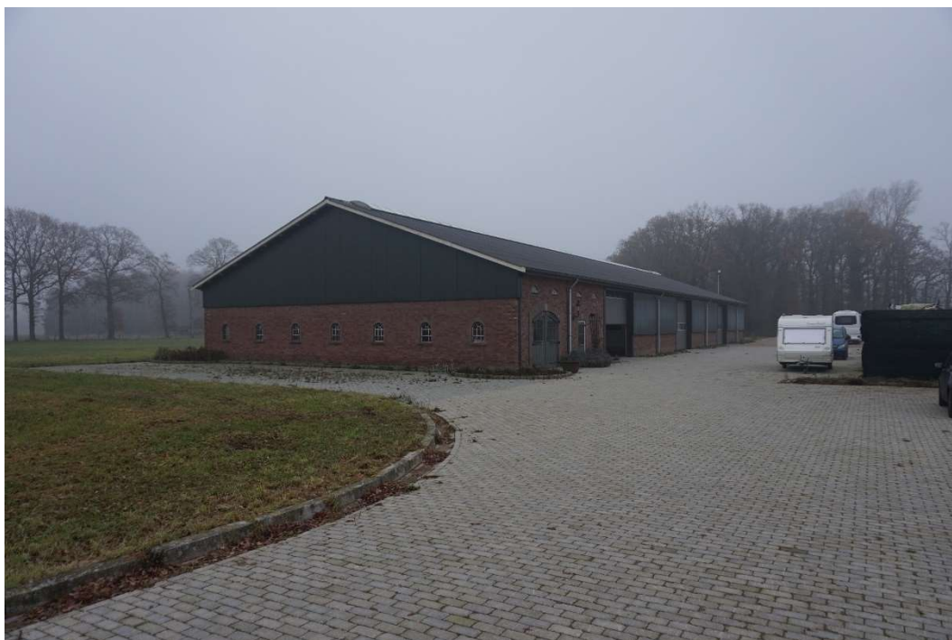
Figuur 2.3. Te slopen loods ter plaatse van het plangebied.
