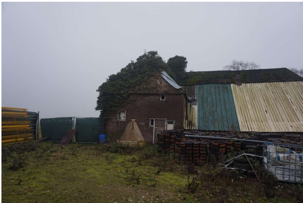
Figuur 2.4. Te slopen vervallen boerderij met aanbouw.
