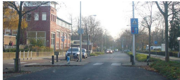
Figuur 26 Voorbeeld van een goede voetgangersoversteekplaats Leeuweriklaan bij basisschool (rijbaanversmalling en attentieverhoging)
