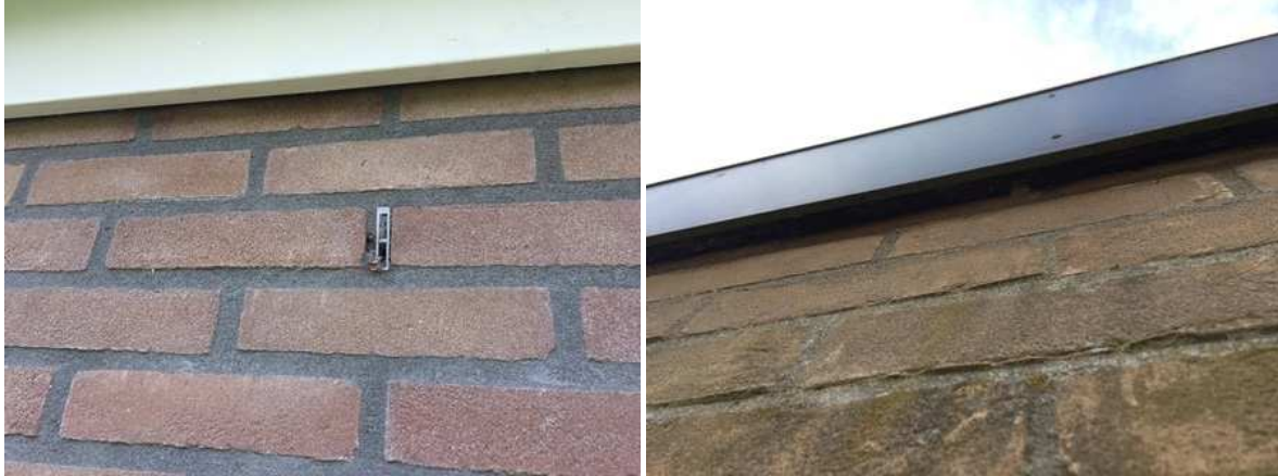
Dichte ventilatieopeningen in stootvoegen en een strak tegen de buitenmuur bevestigde dakplint.
