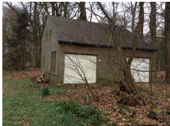
Figuur 8: Overzichtsfoto bebouwing
