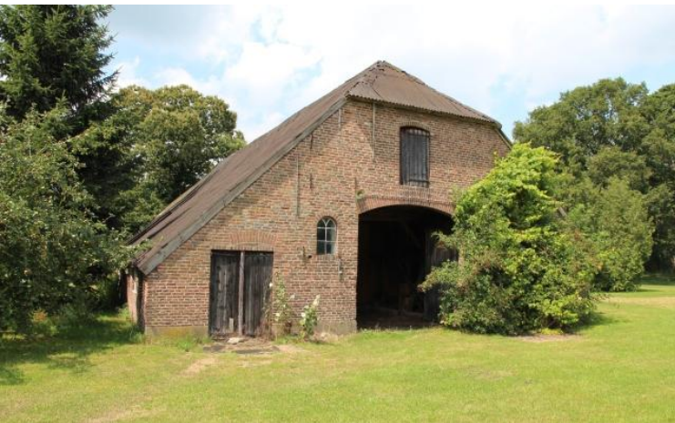
▲ De dubbele wagendeuren naar de deel in de oostgevel van de boerderij. De gevel is in 1926 met hergebruikte bakstenen gebouwd.
