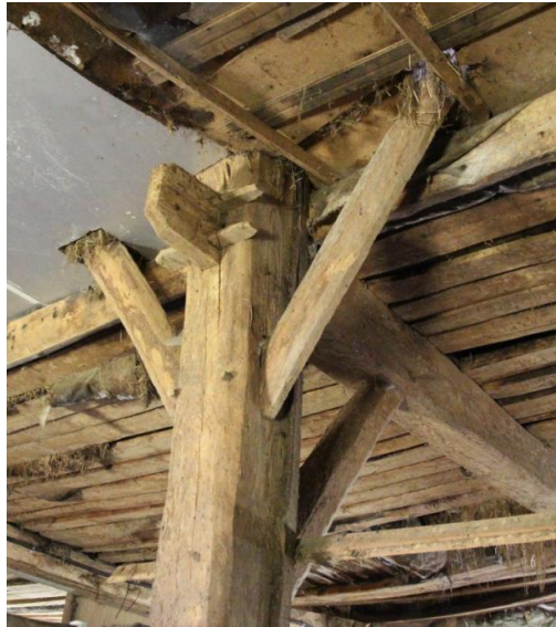
▲ De hoofddraagconstructie van de boerderij bestaat uit ankerbalkgebinten, waarbij de horizontale ankerbalken in de stijlen zijn gepend en met wiggens zijn vastgeslagen.
