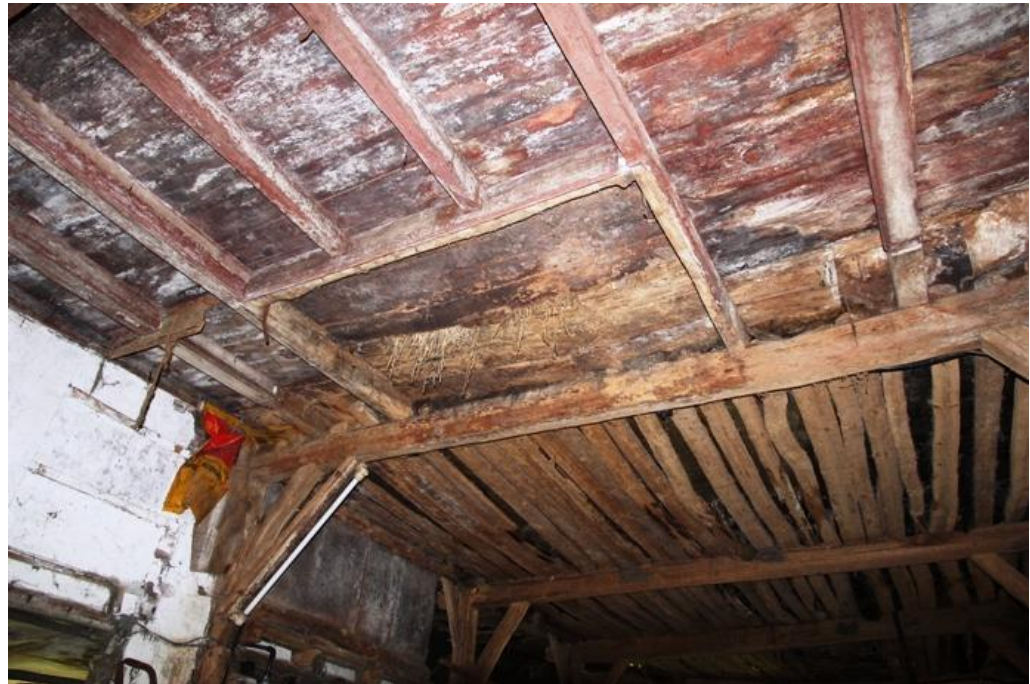
▲ Aan de bovenzijde van de foto de zolderbalklaag in het voormalige woonhuisgedeelte met restanten van een ossenbloedrode verflaag. Verder naar achteren de deel met slieten op de ankerbalken voor opslag van het hooi. Op de overgang tussen de twee balklagen stond een scheidingsmuur met bedsteden. In de balklaag is goed de raveling zichtbaar voor de grote schouw.
