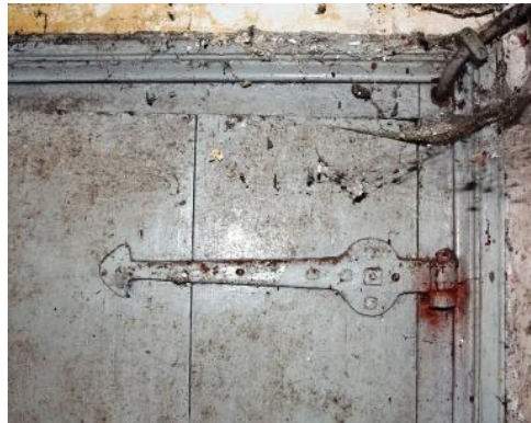
▲ Detail van de deur tussen gang en opkamer met gesmeed geheng, mogelijk daterend uit de bouwtijd van de boerderi.
