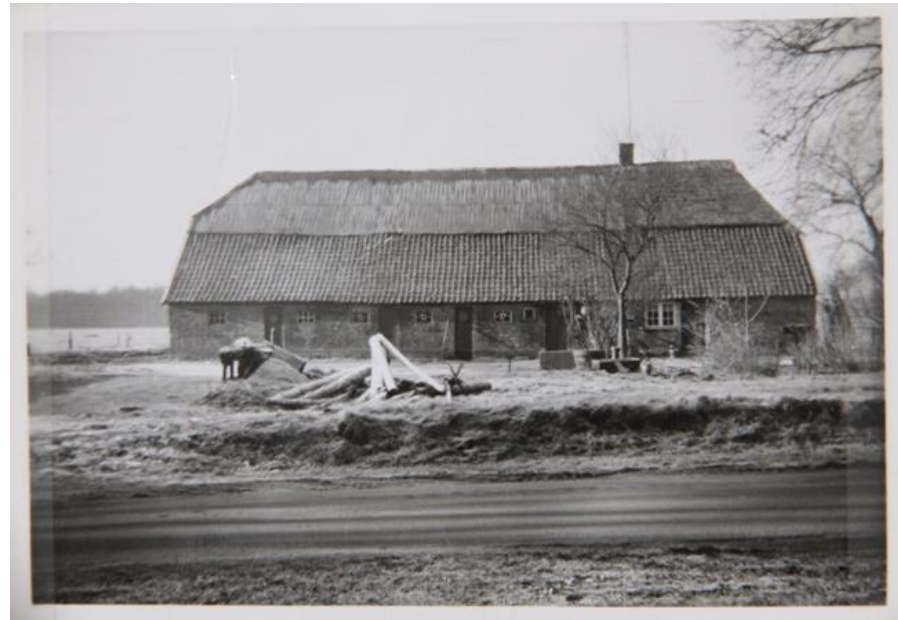
▲ Nijkamp in 1968, vlak voor de bouw van de bungalow. De schoorsteen markeert de scheiding tussen woning en deel.
