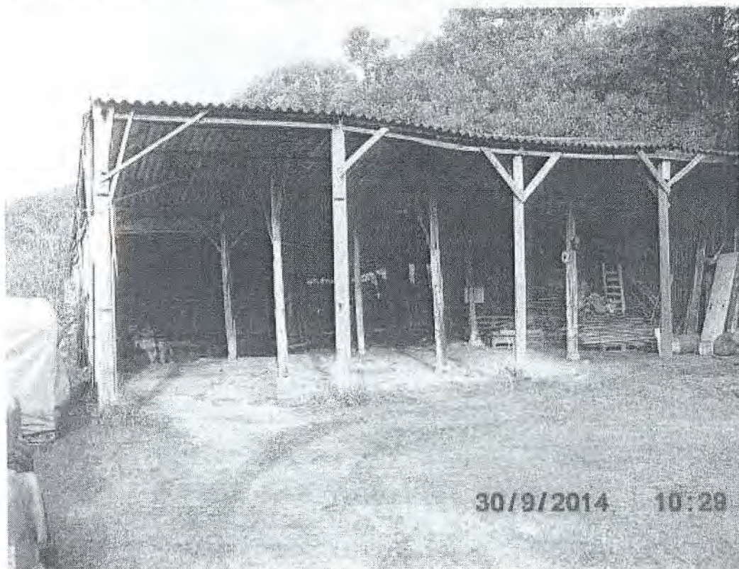
Kapschuur, links achterin de hoek heeft de voormalige bovengrondse olietank gestaan.
