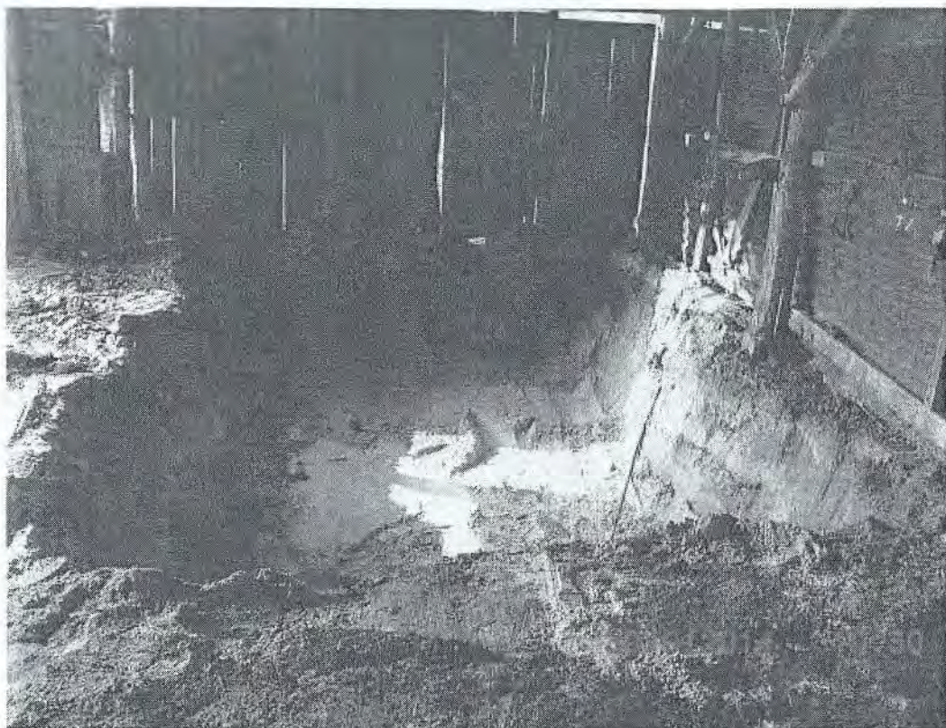
Ontgraven saneringsput (minerale olie verontreiniging). Contour komt overeen met het PVA. Er is ongeveer 18-20 m 3 ontgraven.
