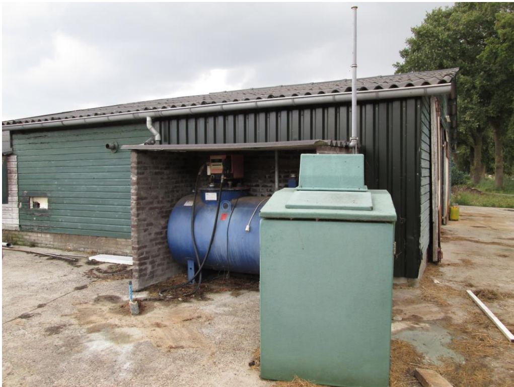
Foto 1: bovengrondse diesleolietank
