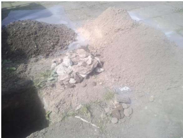
Foto 7. Asbestinspectiegat en opgegraven materiaal gat B6
