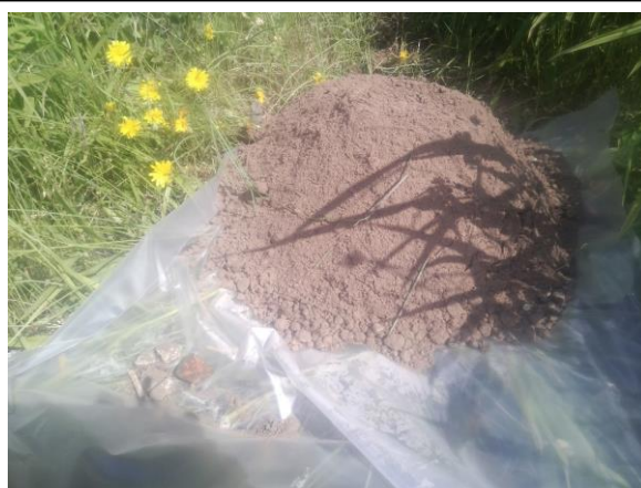
Foto 2. Asbestinspectiegat en opgegraven materiaal gat B1
