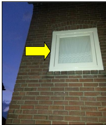
Figuur 9. Invlieglocatie nr.113 verblijfplaats gewone dwergvleermuisen, tussen kozijn en muur.
