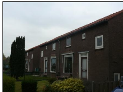
Figuur 4. Voorzijde woningen onderzoekslocatie.
