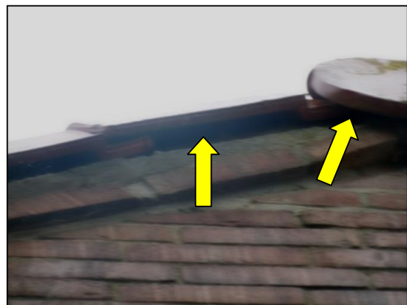
Figuur 11. Ruimte achter nok- en kantpannen.
