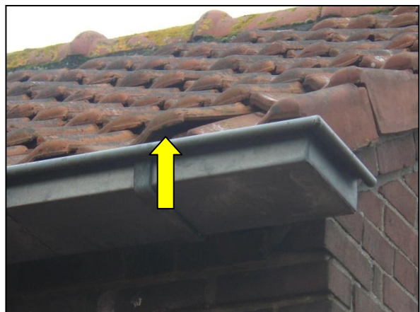
Figuur 9. Ruimte onder dakpan .
