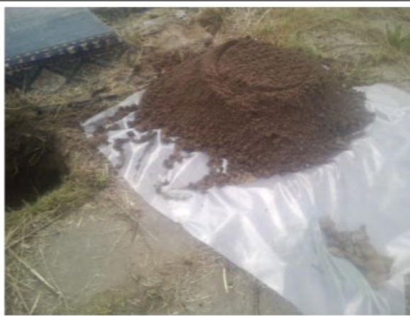
Foto 8. Asbestinspectiegat en opgegraven materiaal gat B7
