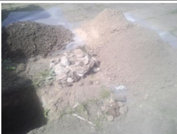
Foto 7. Asbestinspectiegat en opgegraven materiaal gat B6
