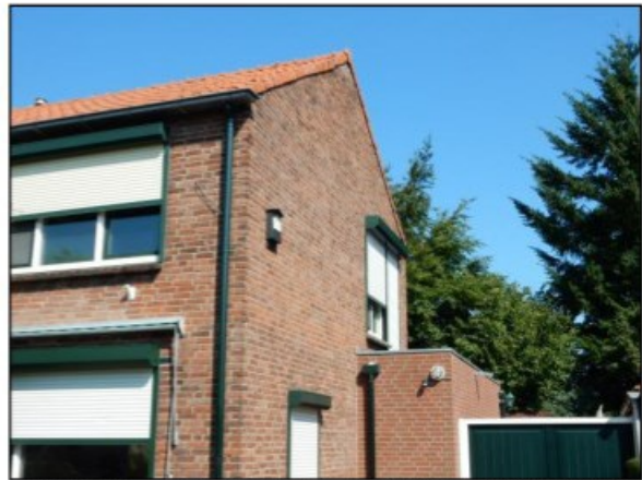
Figuur 14. Vleermuizenkast aangebracht aan woonhuis Hellenlaan.
