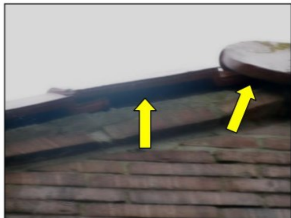
Figuur 11. Ruimte achter nok- en kantpannen.
