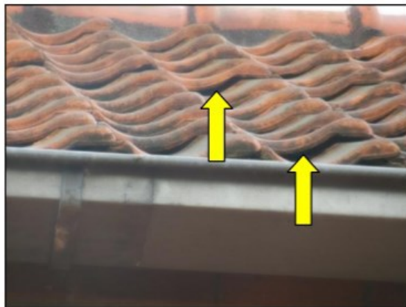
Figuur 10. Ruimte onder dakpannen.
