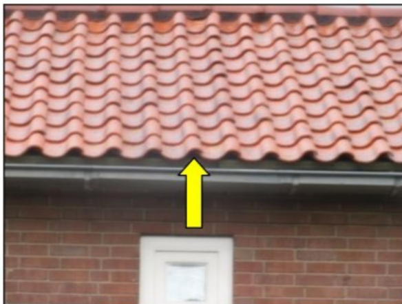
Figuur 8. Potentiële nestlocaties huismus rond dakgoot.
