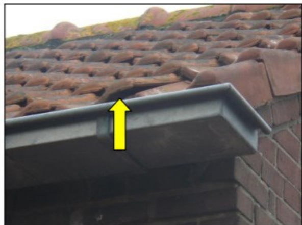
Figuur 9. Ruimte onder dakpan .
