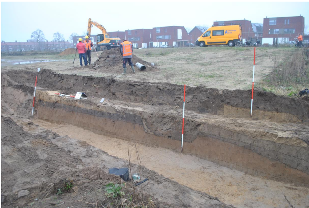
Profiel foto van werkput 1. Links achterin de proefsleuf is de verstoring van de jeugdgevangenis te zien. De bruine akkerlaag vormt de onderste laag en wordt afgedekt door een donkergrijze laag met vooral 18 e eeuwse materiaal. Rechts zijn schuine lagen van de oeverzone te zien.
