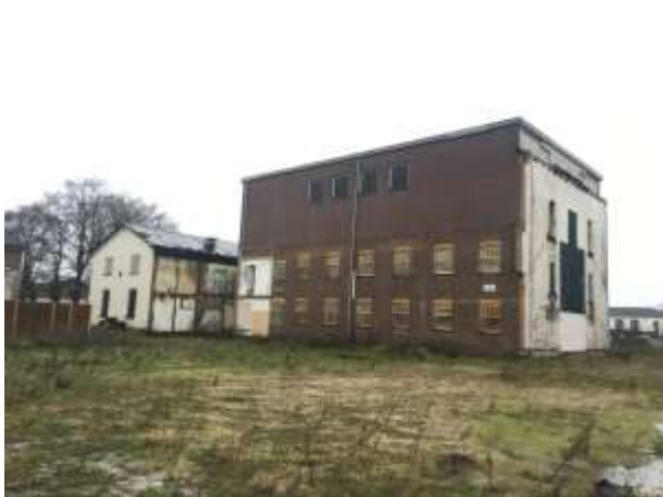
Detailopname van de te slopen bebouwing.
