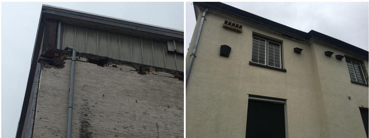
Foto links: in de buitengevels zijn gaten aanwezig. Deze gaten bieden vogels toegang tot het gebouw en kunnen benut worden als nestplaats. Foto rechts: gierzwaluwkasten aan de buitengevel van de te slopen gebouwen.
