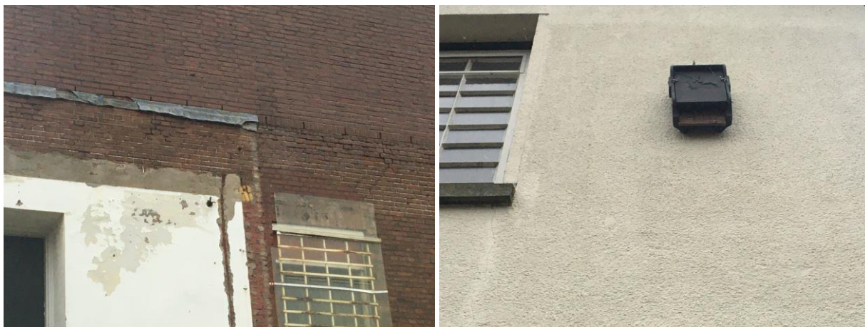
Foto links: open stootvoegen in de buitengevel. Foto rechts: vleermuiskast aan één van de buitengevels.
