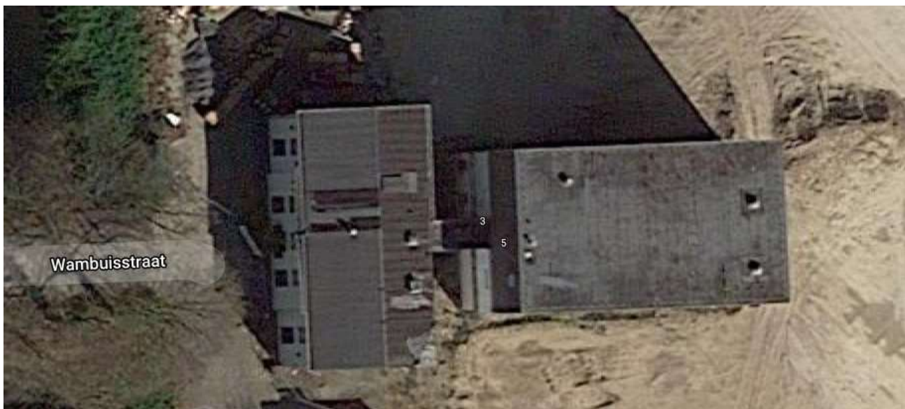
Figuur 2: te handhaven (links) en te slopen deel (rechts) van het gevangeniscomplex – bron: Google Maps
