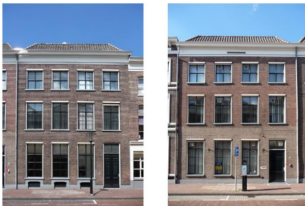
Marspoortstraat 11 en Marspoortstraat 7 (bron: Stichting Torenstad Monumentenbeheer)
