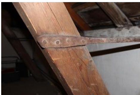
▲ De blokkeelankers dateren uit de bouwtijd en zijn met gesmede spijkers aan de spantbenen bevestigd.
