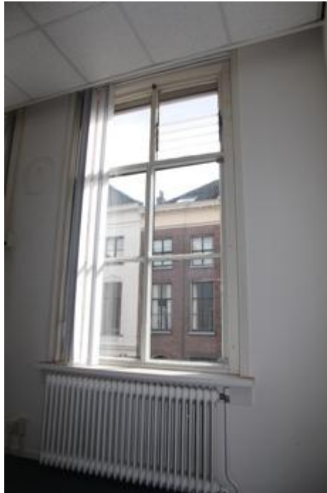
▲ Venster op de eerste verdieping aan de straatzijde. Oude betimmeringen zijn in het verleden verwijderd.
