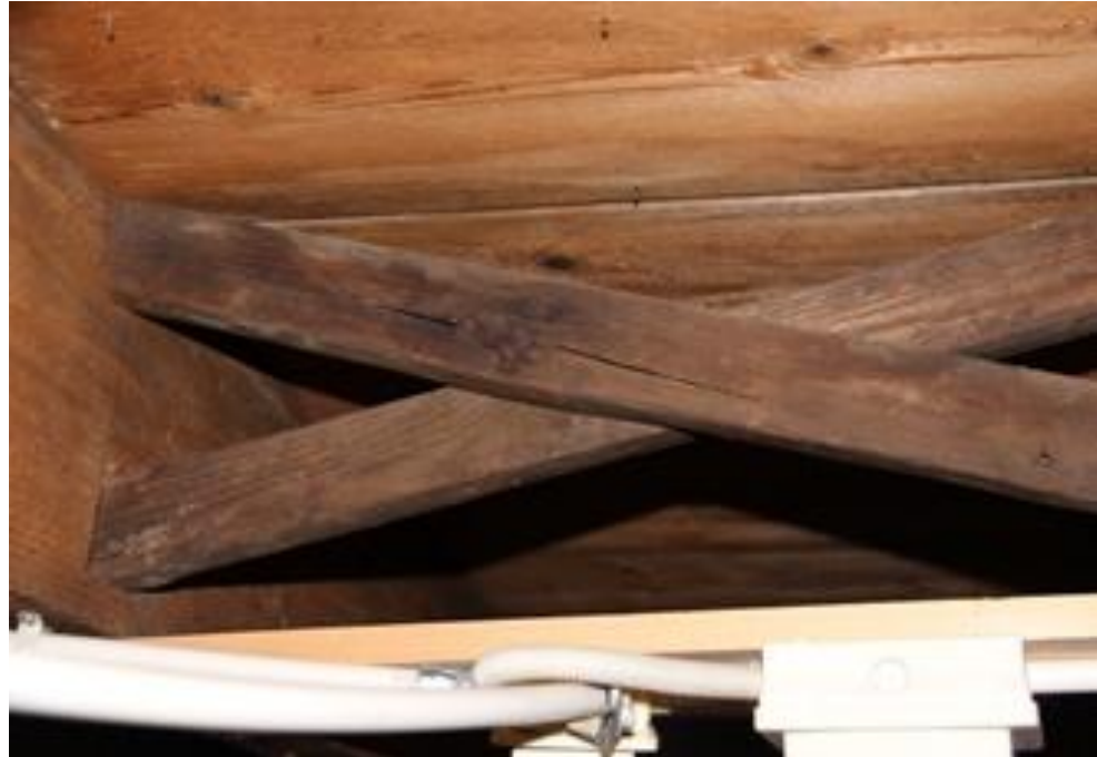
▲ Historische stucplafonds zijn niet meer aanwezig. Daardoor kan wel de historische vloerconstructie goed worden bekeken. Om de vloerbalken te stabiliseren zijn tijdens de bouw in 1870 andreaskruizen tussen de balken gespijkerd met gesmede spijkers.
