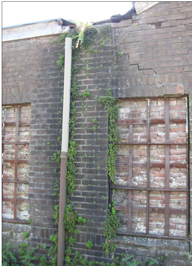
Muurvarrens aan Bolwerksweg (tegenover Schamperdijkstraat).
