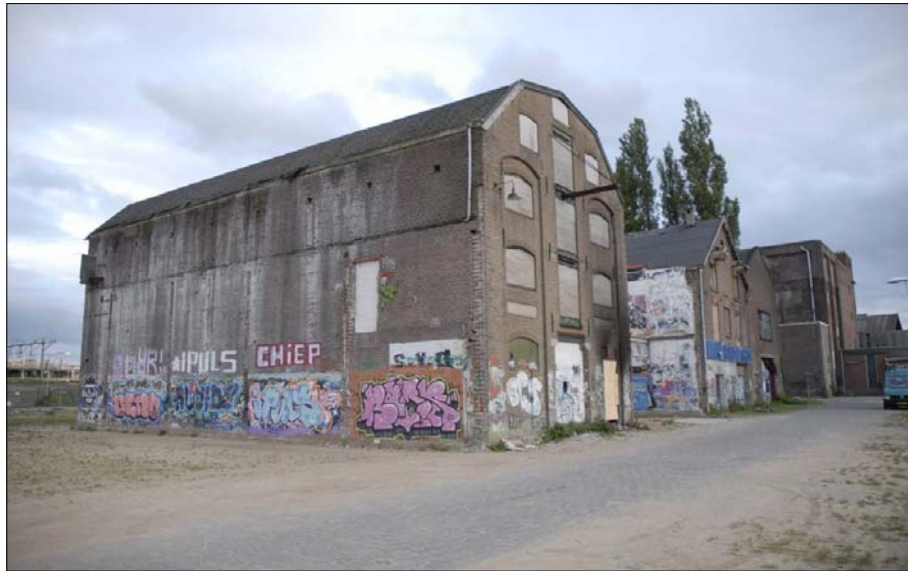
Vervallen panden aan de Noorderhaven.
