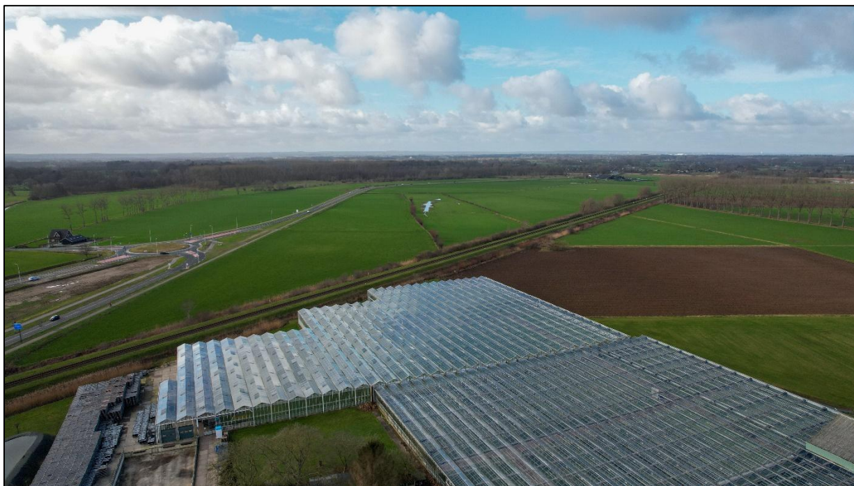
Figuur 44: De spoorbaan en dijk ten oosten van deelgebied 1. Bron: Looije Agro Technics.
