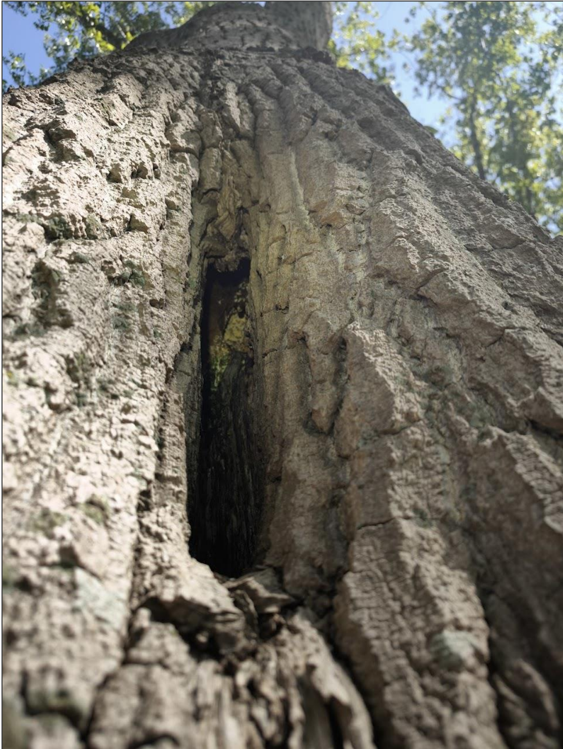
Figuur 2. Poplieren boom met een naar boven ingerotte holte. Foto: L.N. Ion, 2025.
