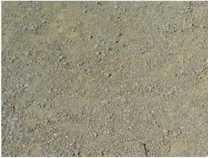
zandgele halfverharding, opsluiting van verdiept aangebrachte opsluitbanden
