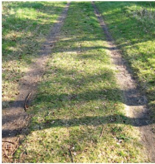
karrenspoor, slijtlaag de ondergrond verstevigen met 20 cm grof puin
