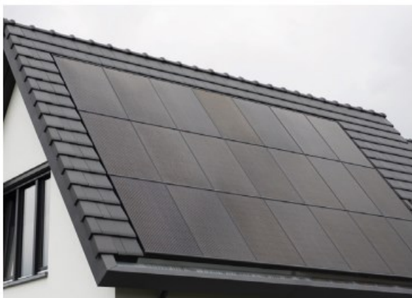
Zonnepanelen op daken (in principe niet direct zichtbaar)
