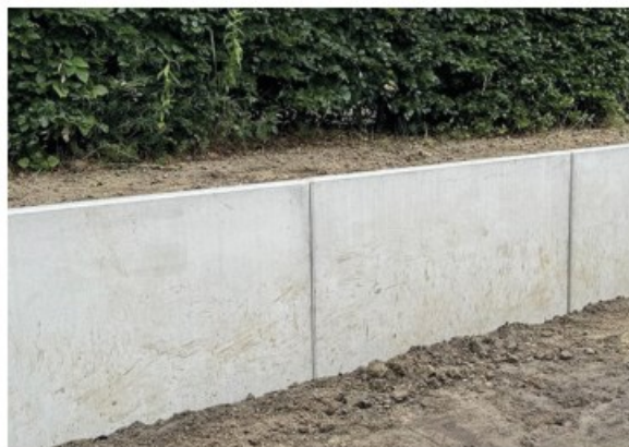
Kerend L-element beton, particulier eigendom
