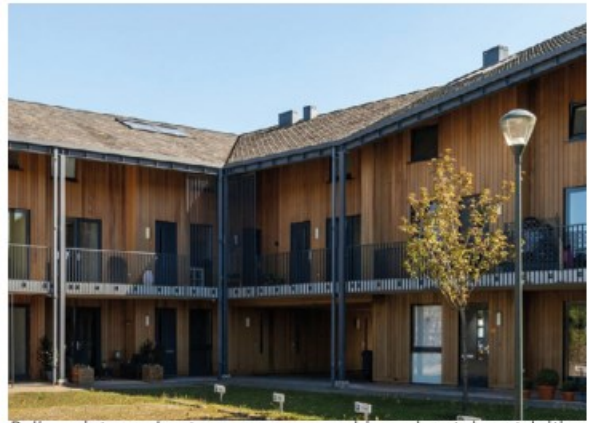
Balkons integraal ontworpen en gecombineerd met de ontsluiting
