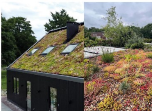
Groene daken op appartementen en bergingen
