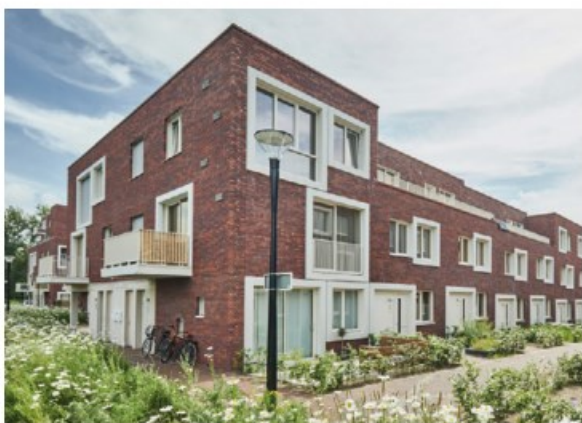
Appartementen van 3 bouwlagen
