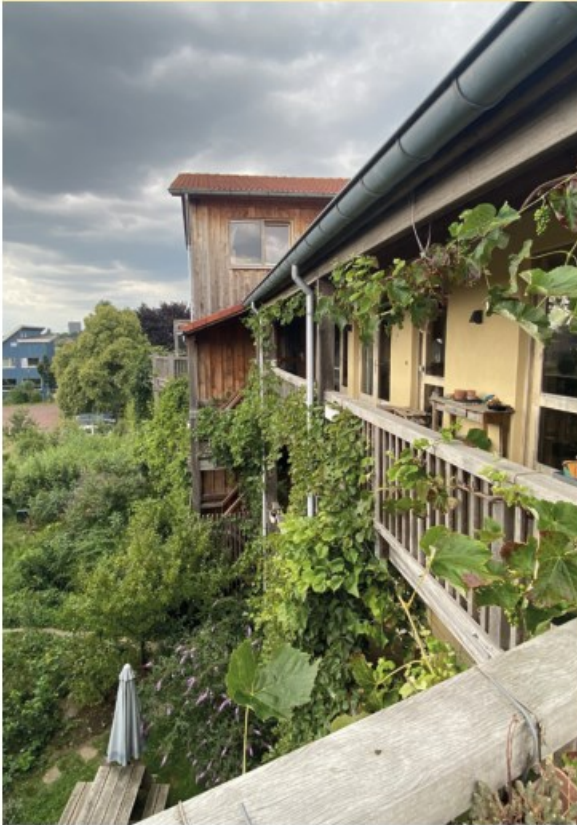
Gallerij met gevelbeplanting grenzend aan tuin, zadeldak Iewan Nijmegen (Bron: BSLA)
