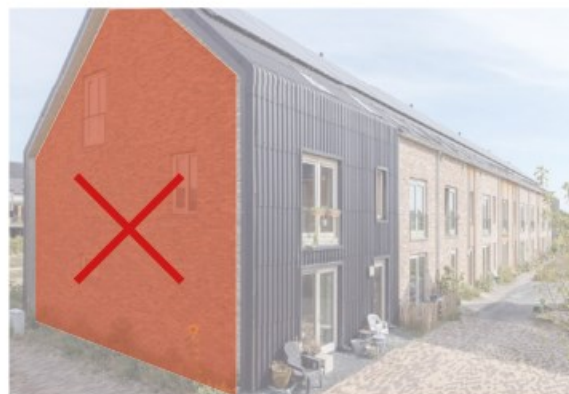
geen gesloten kopgevel, wel verbijzondering in materiaal
