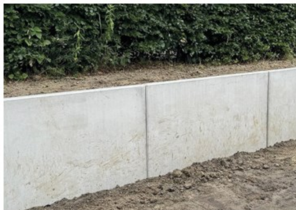
Kerend L-element beton, particulier eigendom
