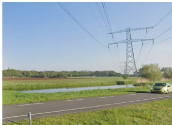
Hoogspanningsmast in het plangebied (foto: BSLA)
