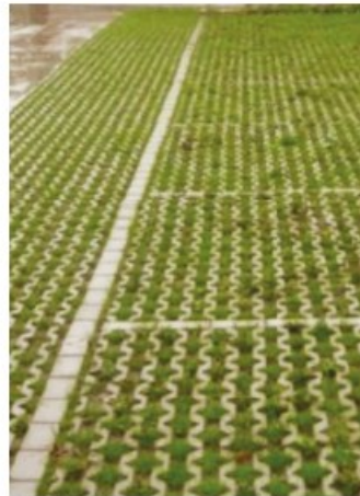
Gescheiden parkeervakken met strekkenlaag (gebakken materiaal)
