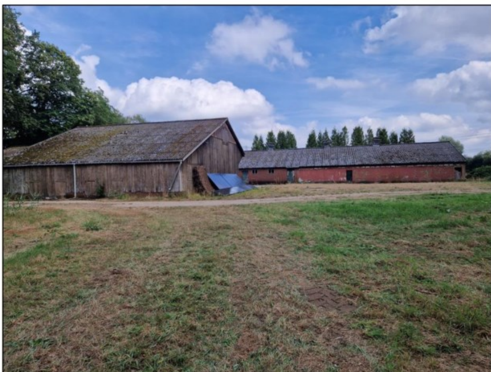
Figuur 9. Schuren behorende bij woning Kerkhofweg 1 (rechts) en Kerkhofweg 3 (links). Schuur behorende bij Kerkhofweg 3 is open aan de achterkant.
