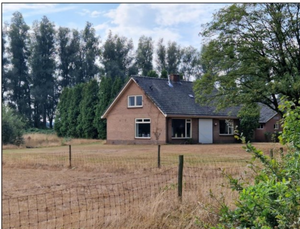
Figuur 7. Woning Kerkhofweg 1.
