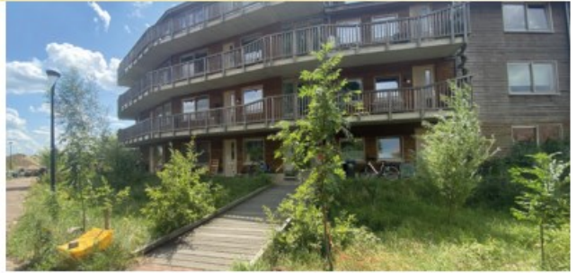
Wateropvang op het terrein
