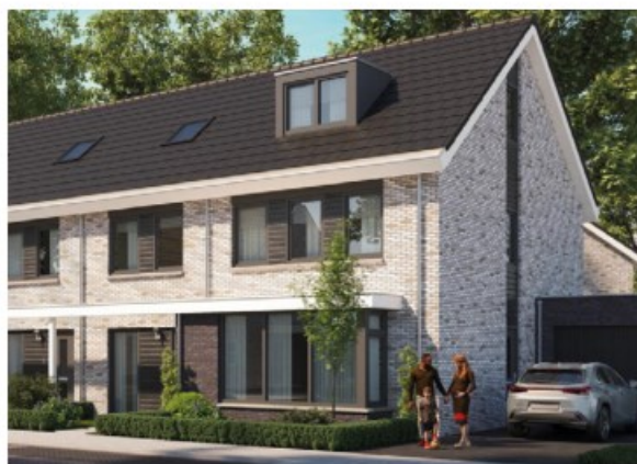
Hoekwoning met raam op dak en glassteen aan de zijgevel
