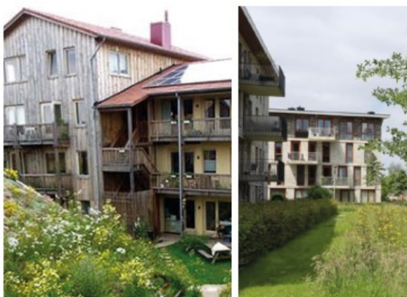
Appartementen van 4 bouwlagen, duurzaam wooncluster Iewan (links) & Mix architectuur - Prinsessenpark (rechts)
