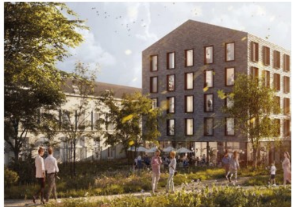
Balkons volledig inpandig
