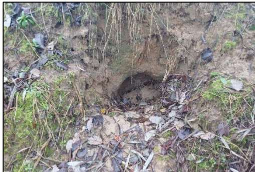
Figuur 2.11. Ingestorte vluchtpijp.
