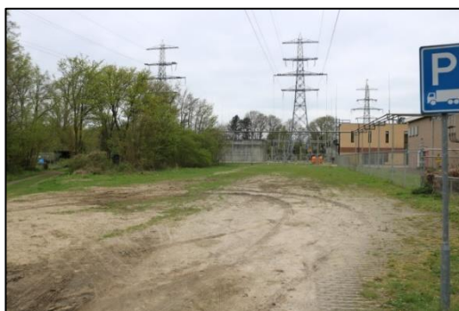
Figuur 4.18. Hoogspanningsstation noordzijde.
