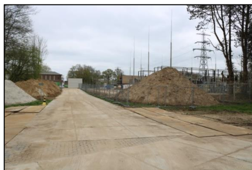
Figuur 4.17. Hoogspanningsstation zuidzijde.
