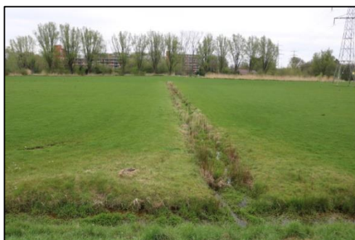
Figuur 4.16. Te passeren greppel middels open ontgraving.
