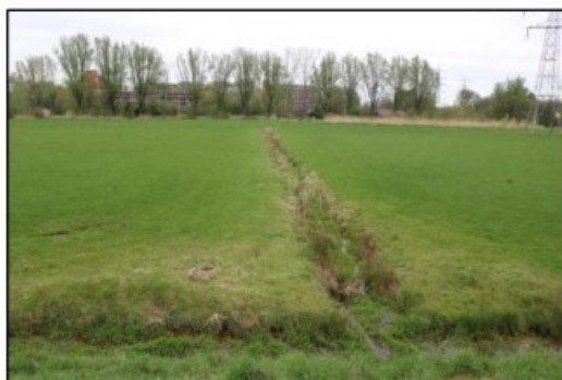
Figuur 4.16. Te passeren greppel middels open ontgraving.
