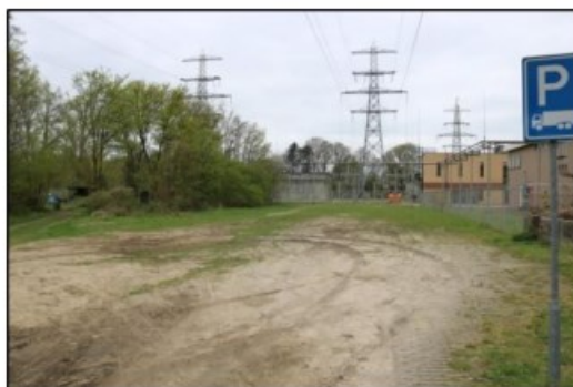
Figuur 4.18. Hoogspanningsstation noordzijde.
