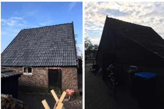
Figuur 4: schuur 3, oude vee/opslag schuur
